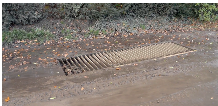
Foto: combineren van onderdelen kan handig zijn, hier is de afvoerput midden in het erf aangelegd, om ook slib af te vangen
