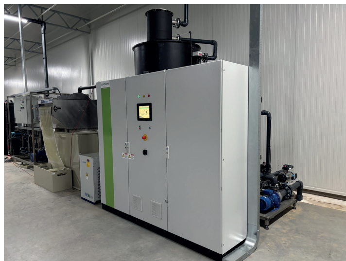
Foto (copy right Agrozone): fysisch-chemische zuiveringssysteem (ozon) om al het water dat op het erf terecht komt te behandelen.
