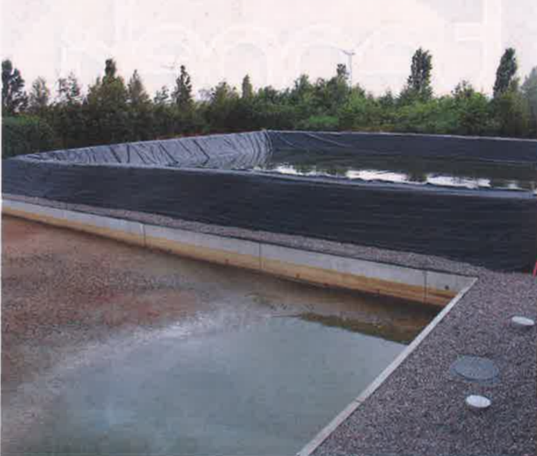
Het slib slaat De Kubbe op in het voorste bassin. In het achterste het water.
